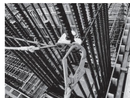
柱または梁筋から安全ロープを取りための墜落災害防止用の金物です。
