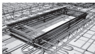
③ ガイザー板施工例
