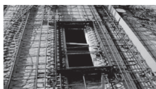
④ FR板施工例
