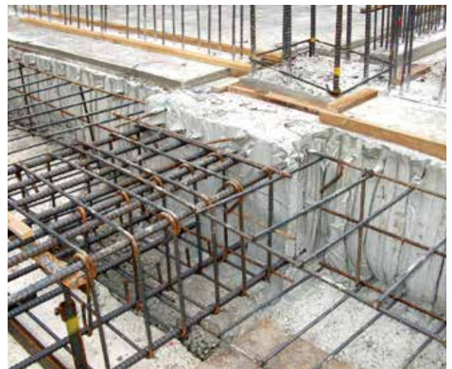
⑥ スポコン撤去後(打継面)
