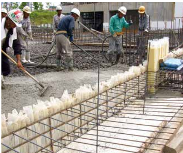
③ コンクリート打設中
