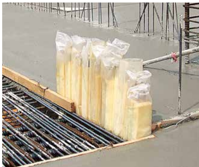
③ コンクリート打設後
