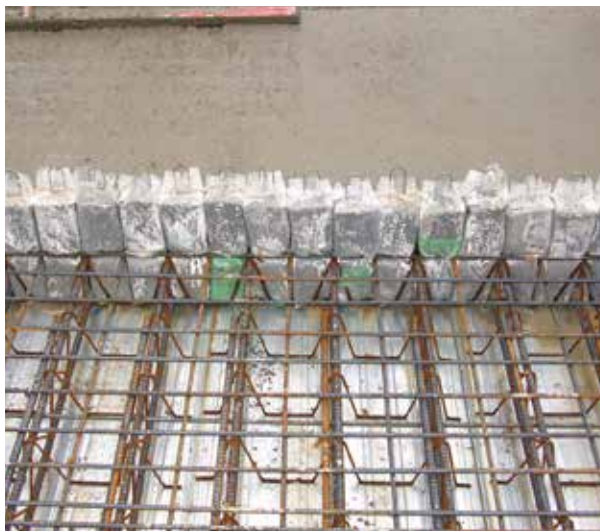
② フェローデッキ (CON打設中)
