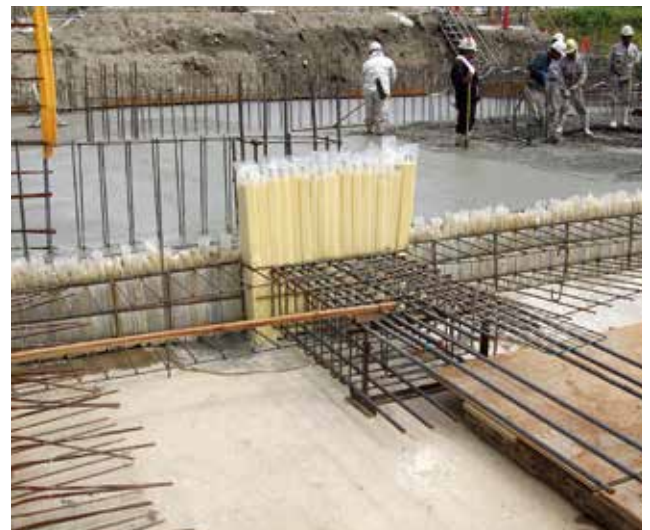
④ コンクリート打設後
