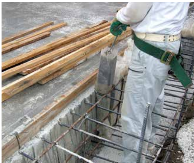
⑤ スポコン撤去中
