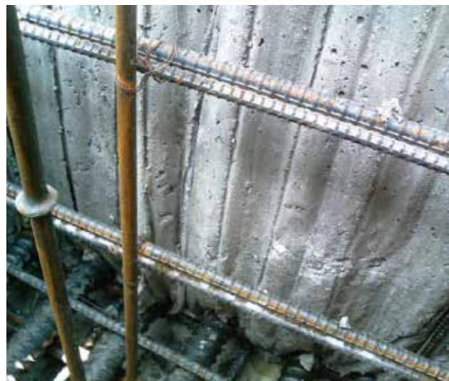
⑥ スポコン撤去後 (打継面その2)
