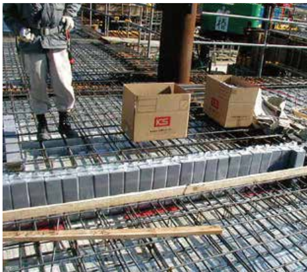
① フラットデッキ (設置その1)
