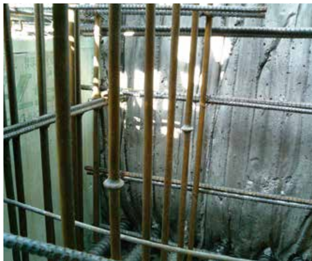
⑤ スポコン撤去後 (打継面その1)
