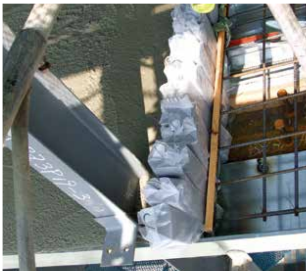
③ QLデッキ (CON打設中)
