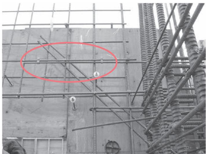
重ね継手として使う壁筋の定着筋を「カニのツメ」により仮止めしておき、のちに定着筋をスライドさせることで継手位置と定着長をバランスよく配置できます。
