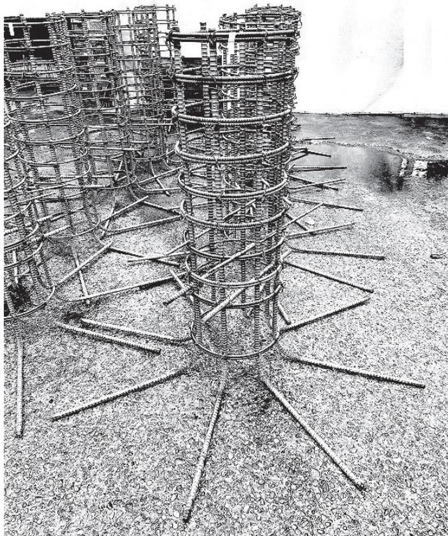
既製コンクリート杭の杭頭部へ挿入する杭頭補強筋を製作します。
