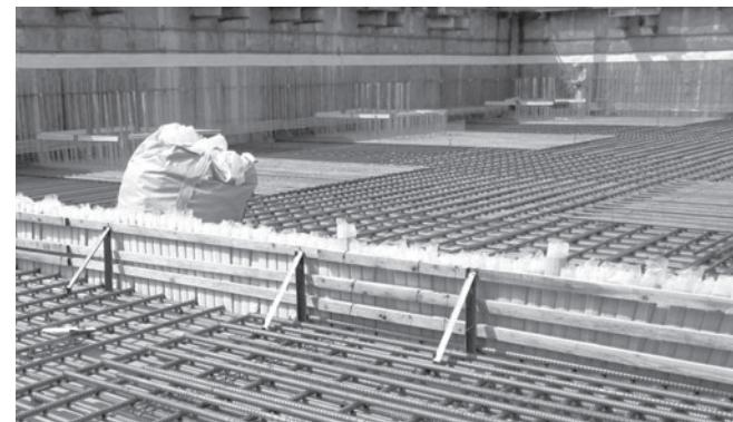
梁のコン止めにスポコンを用いる場合は、生コンの側圧でスポコンが湾曲しないようあら筋などへ直交向きにD13のカンザシ筋を300ピッチ以内に結束し補強してください。
