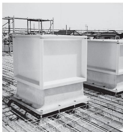
屋上スラブ貫通部の通称「ハト小屋」をユニット化することで、配筋、型枠、脱型などの工期短縮になると同時に産廃の少量化にも貢献します。
